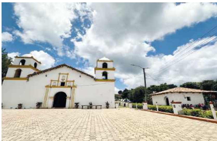
Imagen 6. Frontispicio de la iglesia católica «Parroquia Santa Lucía Virgen y Mártir» del municipio de Yamaranguila, Intibucá, ubicada en su casco suburbano. A su costado derecho (desde la fachada), se encuentra la casa de la auxiliaría de la vara alta de Moisés.
